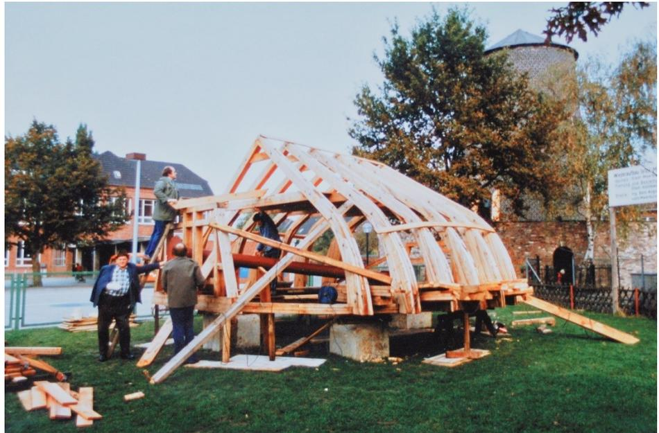
Radmacher gefertigt und provisorisch aufgestellt. Wenn die Baugenehmigung durch die Stadt erteilt ist, soll mit der endgültigen Montage an der Mühle begonnen werden. Diese Montage der Mühlenhaube erfolgt fix und fertig auf dem Boden, so dass dann mit Hilfe eines Autokrans das Dach in kurzer Zeit auf den Stumpf gesetzt werden kann. Natürlich muss vorher noch das alte Dach entfernt werden.
