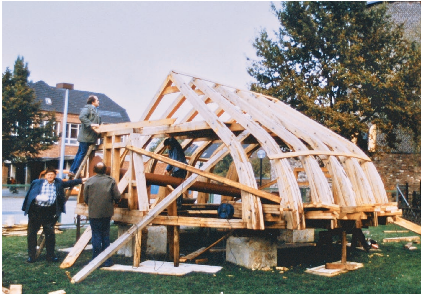
Zimmermannskunst: Die Haube für den Mühlenturm wird vor dem Aufsetzen nach historischem Vorbild gezimmert und abgedichtet. Fotos (2): Heimatkreis
