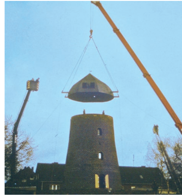
Spannender Moment: Die „Holländische Haube“ schwebt an ihren Platz hoch über Lank-Latum.
