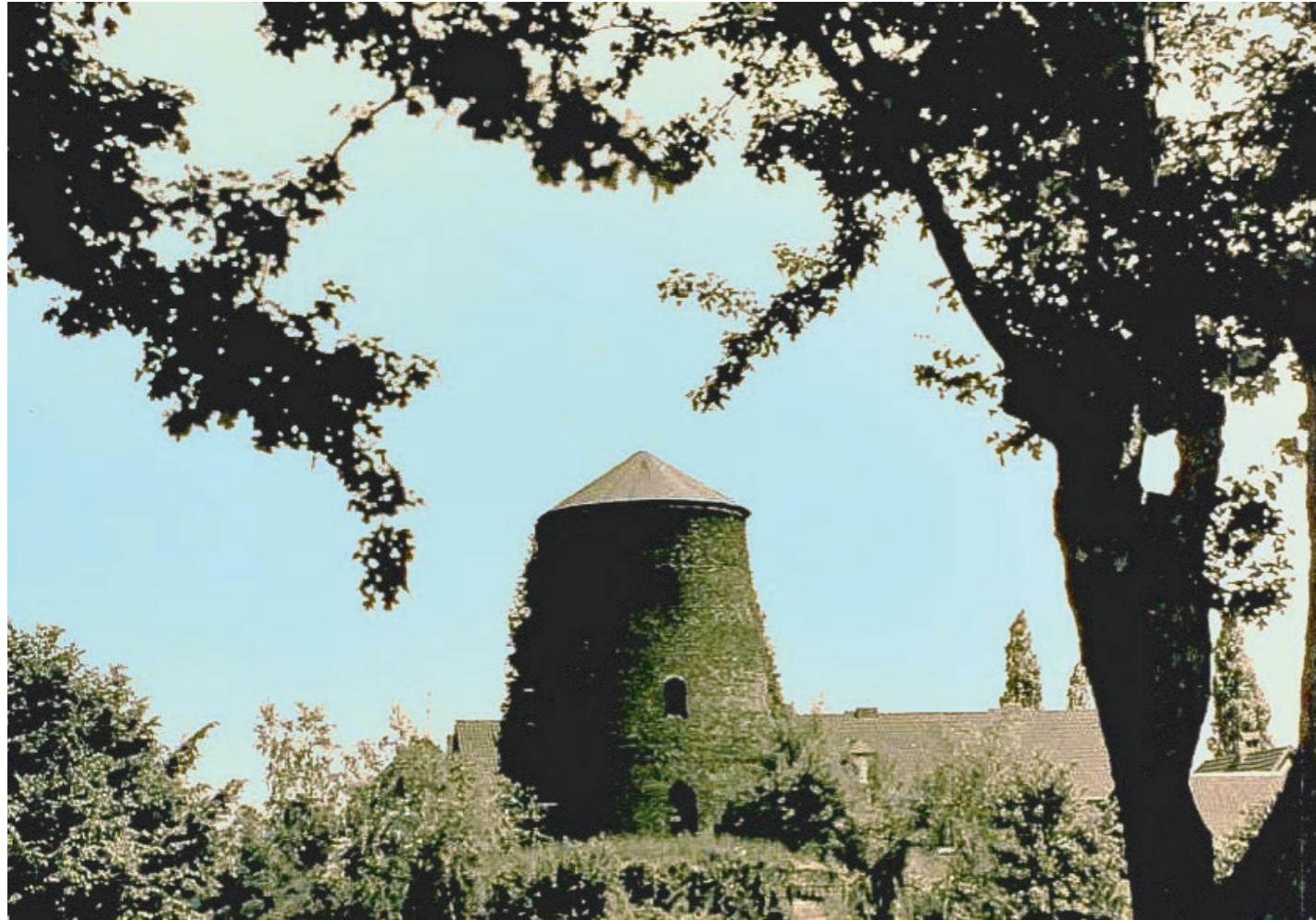
Jahrzehntelang präsentierte sich die Teloy-Mühle im Lank-Latumer Ortskern als Turmstumpf mit „Chinesenhut“. Mit der historisch belegten „Holländischen Haube“ hatte das Provisorium freilich nichts gemein.
