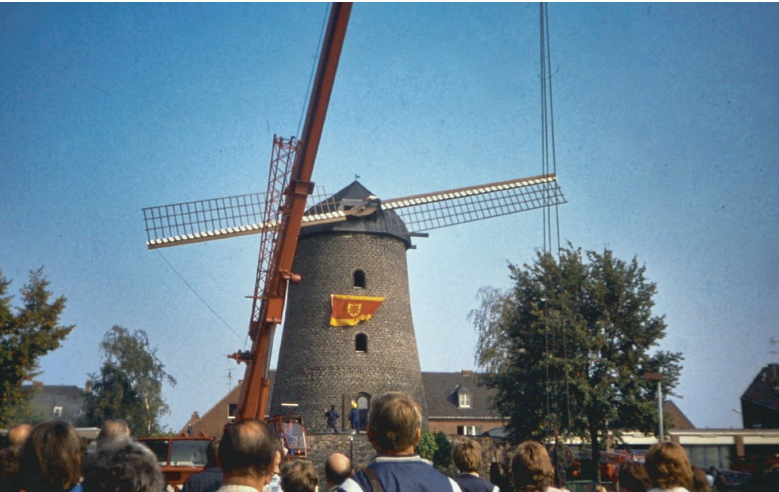
Attraktion im Oktober 1982: Das zweite Flügelpaar schwebt am Haken eines Schwerlast- krans auf seine Stahlachse.
